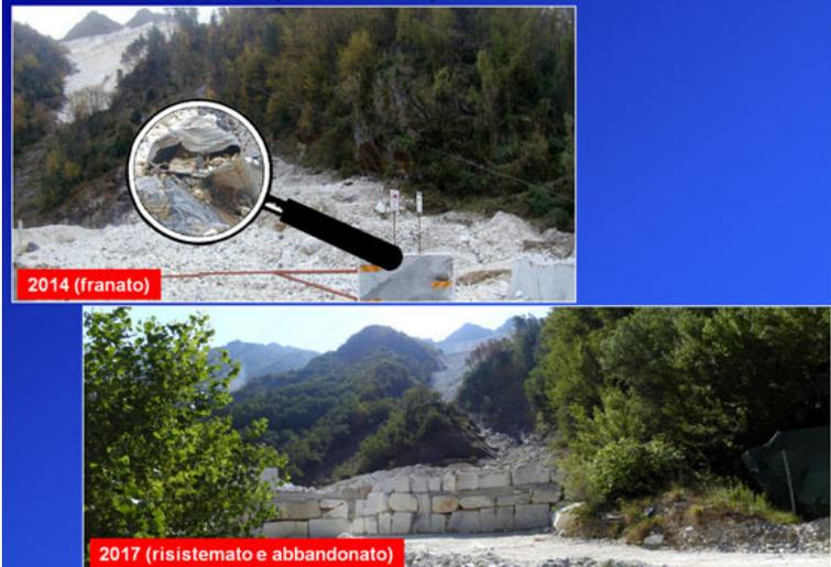
Lavoro inutile, visto che nel 2014 il ravaneto è nuovamente franato (seppellendo il tubo di drenaggio in corrugato metallico). Tanto è vero che poi è stato definitivamente abbandonato e stabilizzato con una barriera di blocchi al piede.
